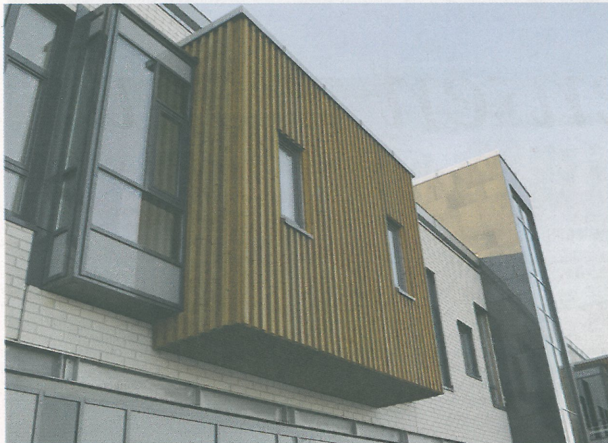
På en spennende måte blir fasaden i glass, metall og stein brutt opp av trekledde karnapp. Innenfor ligger baderom som måtte skyves ut for å gi plass i senteret av sengetunet.
