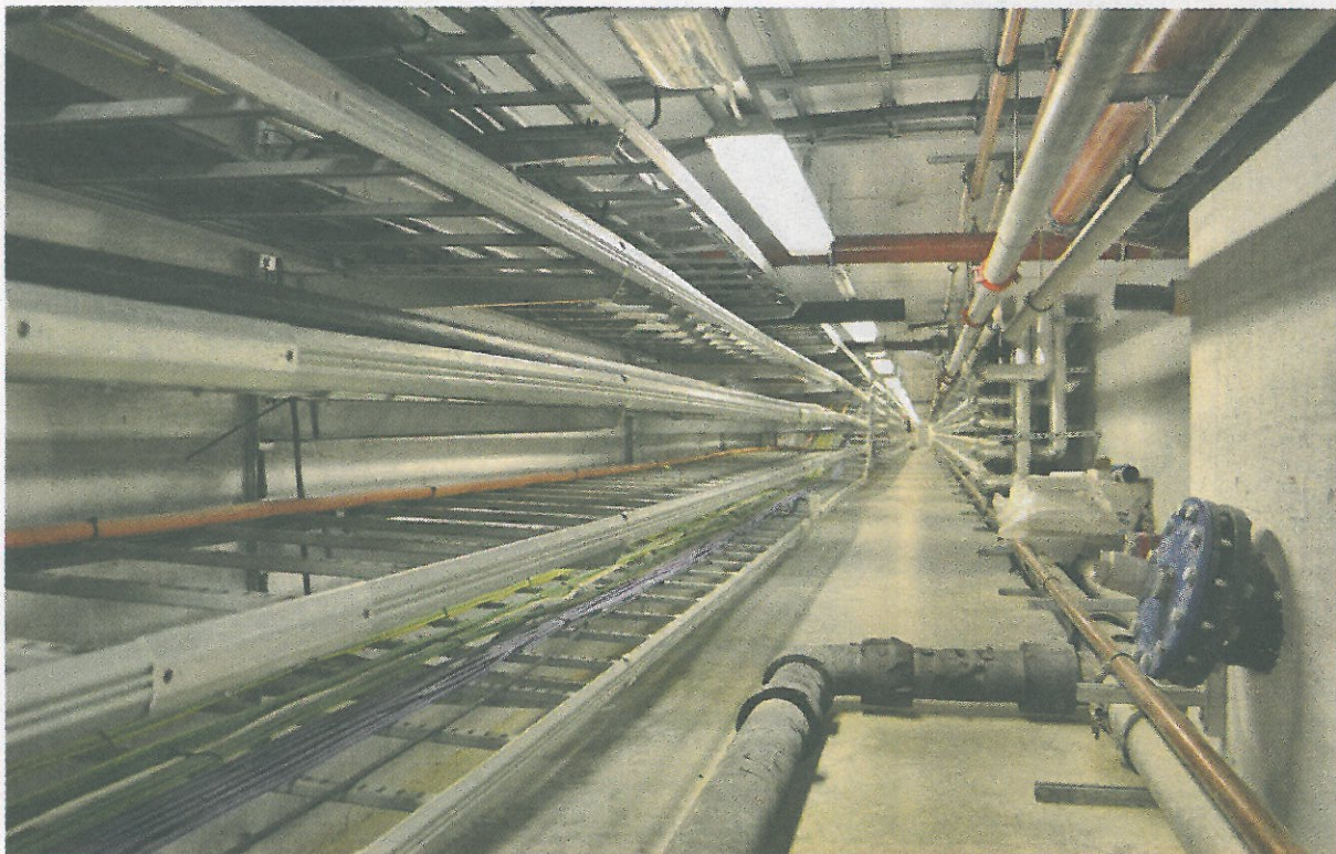
I 160 meter lange kulverter under hver fløy går det kabler og rør som forsyner sykehuset med vann, strøm og datatrafikk.
